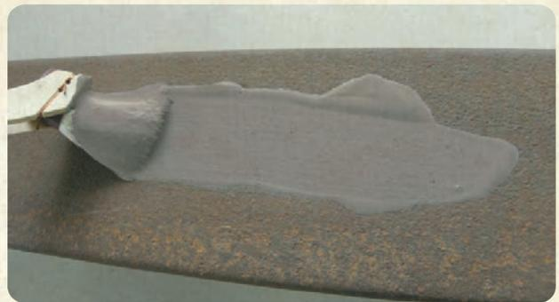
原液のまま塗ってみて、塗りにくければ水で5パーセントまでの量で薄めます。また錆の凹凸がかなり深い場合は中まで浸透しにくいので、刷毛やローラーで奥まですりこむように塗ってください。(水で薄めすぎると効果が著しく低下します)
