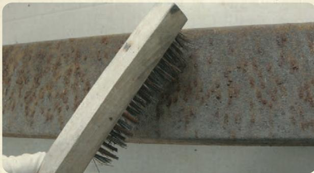
まず塗装したい面の簡単に落ちる旧塗膜や浮錆を落とします。なかなか落ちないよくひっついてる旧塗膜や浮錆はそのまま大丈夫です。その他ほこりや粉のように触ってすぐにぼろぼろ落ちる錆、油分は取り除きます。またつるつるとした面ではかすれたりする場合がありますので、粗めのサンドペーパー(#150番程度)で目荒らしをしてください。
